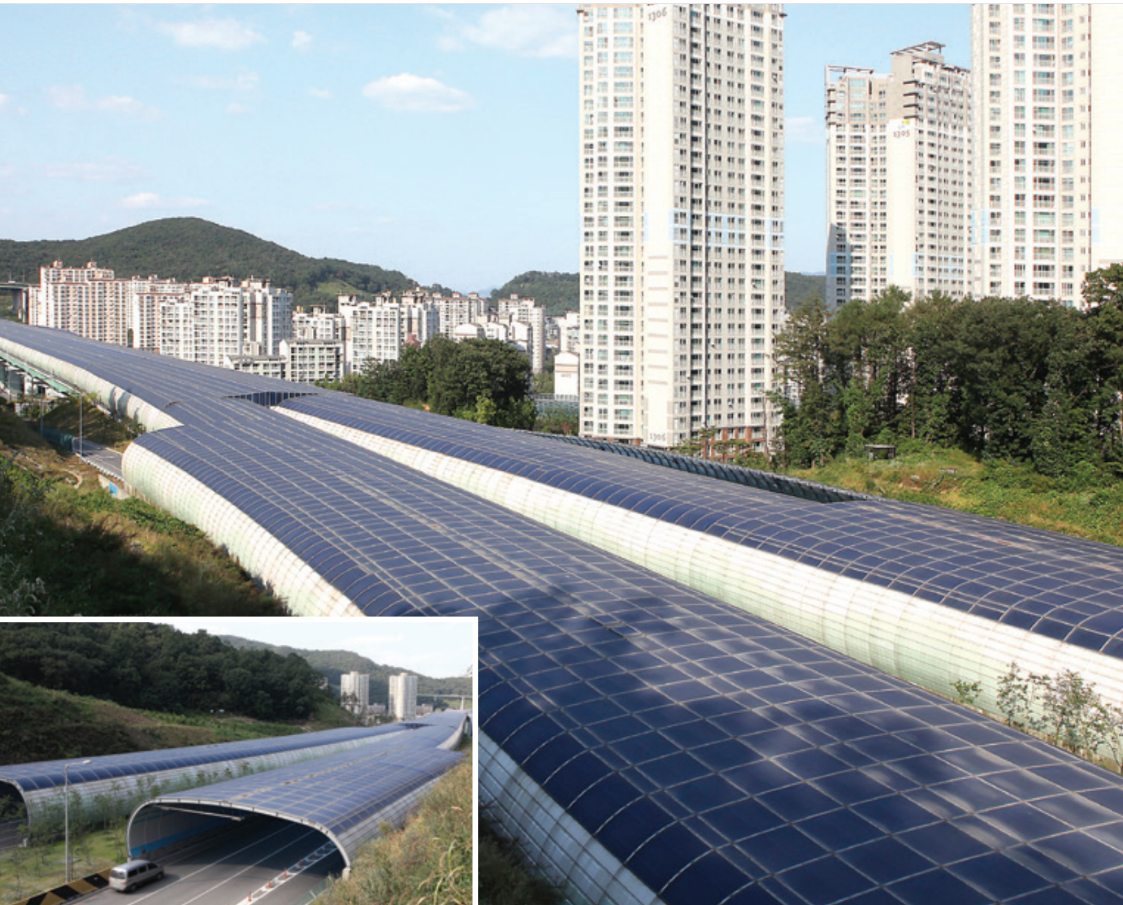
터널형방음벽(흡음+투명) 외부 전경
